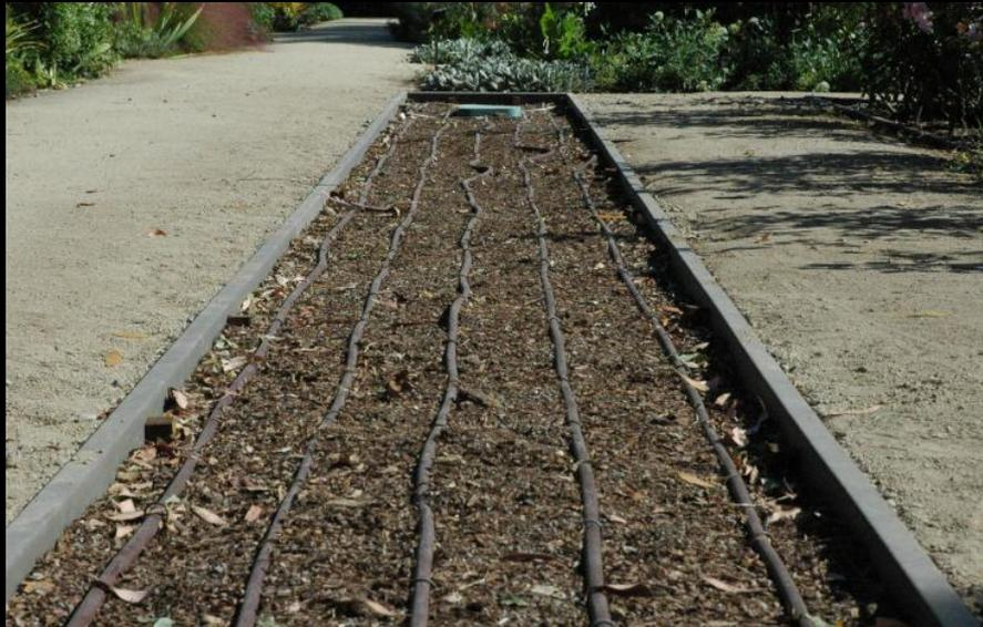
Esta línea de goteo está instalada a 12" X 12" y el flujo por gotero es de 0.42 gph. Cuál es la tasa de precipitación?
