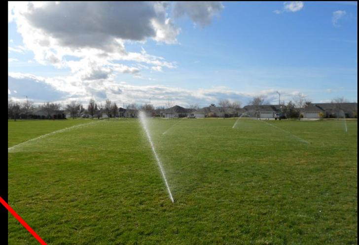
*Cuando el rotor se ajusta a círculo completo, la tasa de precipitación baja a solo 0.22" / hr*
